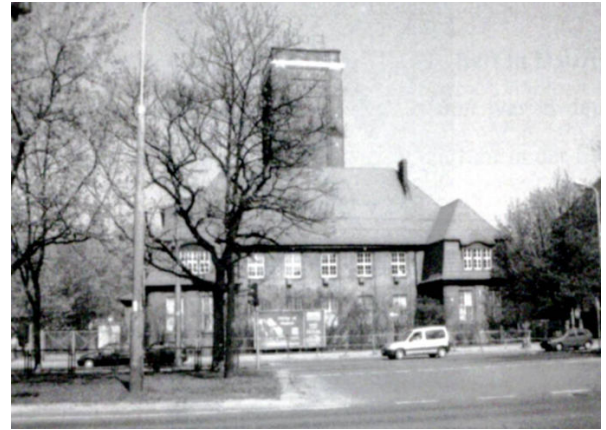
Abb. 3: Ansicht des Gebäudes im Jahre 2006, Institute der Universität Danzig Phot. Peukert, Mai 2006
