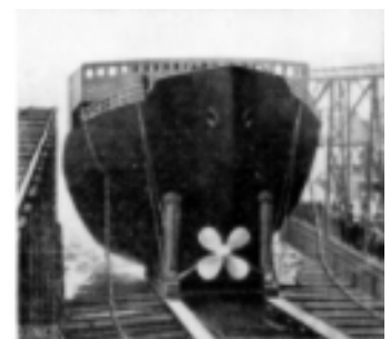
Bild 7. Vorschiff mit Bugschraube
