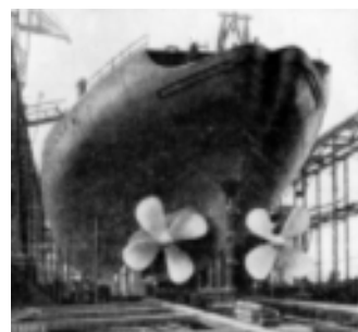
Bild 6. Hinterschiff mit den beiden Heckschrauben. Auch der Schleppschlitz ist deutlich zu sehen.
